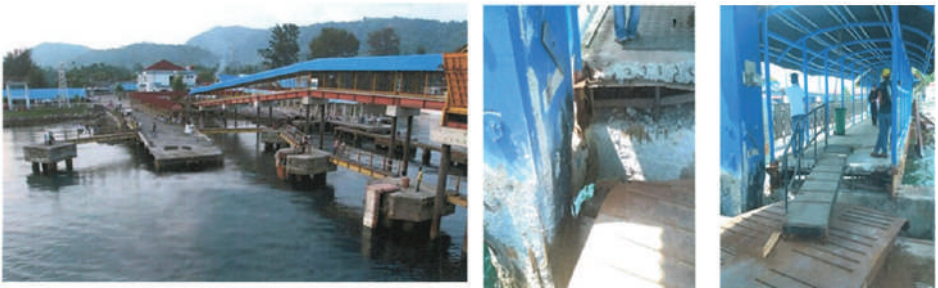
Gambar 42. Kondisi Pelabuhan Nasional Balohan
